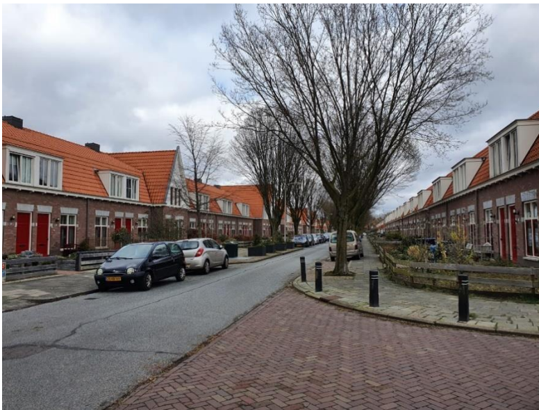
Foto 4: Renovatie Dr. Schaepmanlaan
