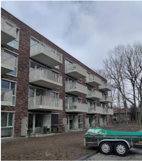
Foto 1: Nieuwbouw Cornelis Vlotlaan
